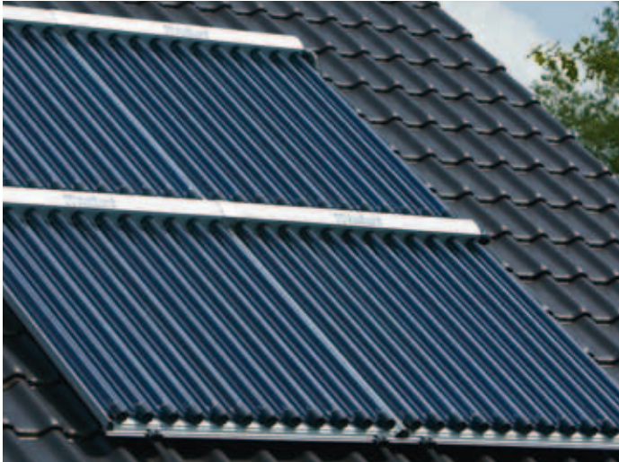
Cevni kolektori montirani na kosi krov
