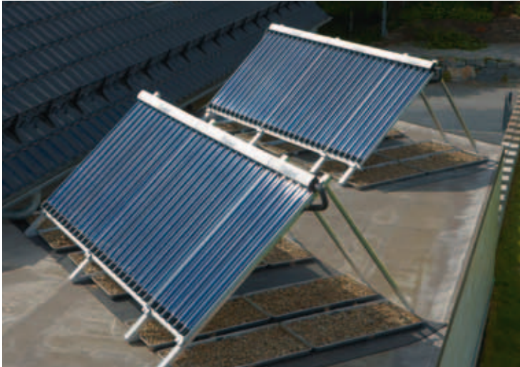
Cevni kolektori montirani na ravni krov
